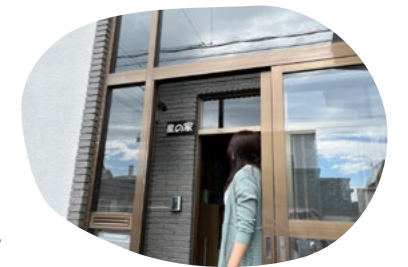
「星の家」玄関にて。玄関前には、室内への雪や風の吹き込みを防ぐ風除室がある。
