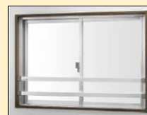
転落防止の手すりの設置
