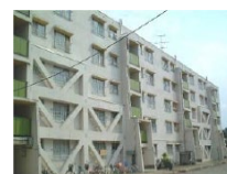
共同住宅 (外付けフレーム補強)
