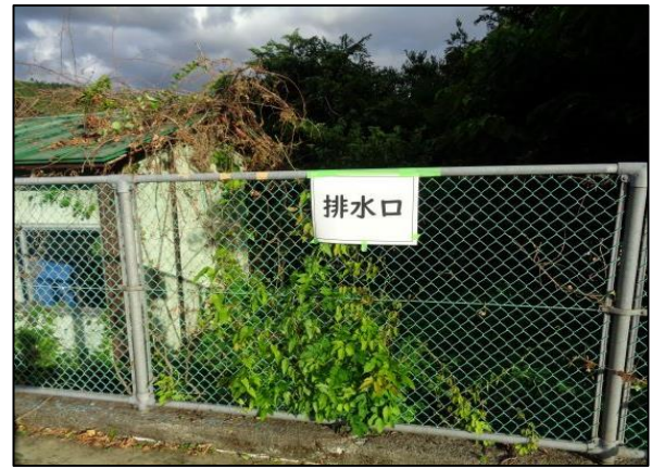
南側フェンス（深いプール側）
