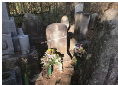
図2：転倒した墓石（縦78.5cm x 横38cm x 奥行20cm 139kg）[1]
