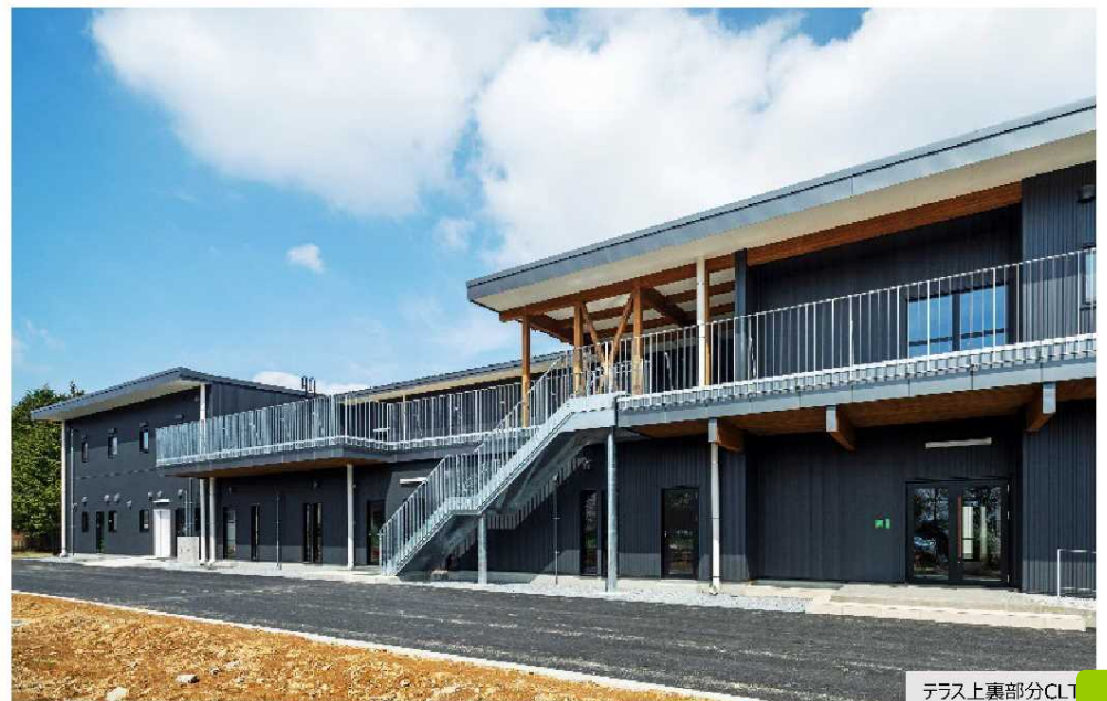
テラス上裏部分CLT
