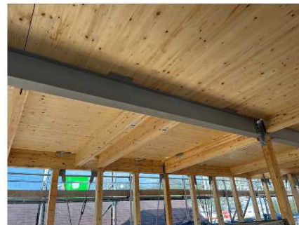
1階天井（2階床）CLT（工事中）
