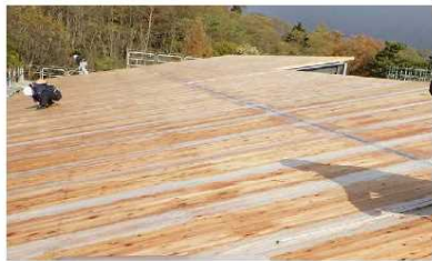
屋根CLT（工事中）
