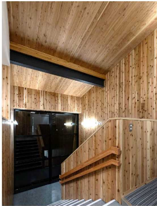
天井（屋根）CLT
